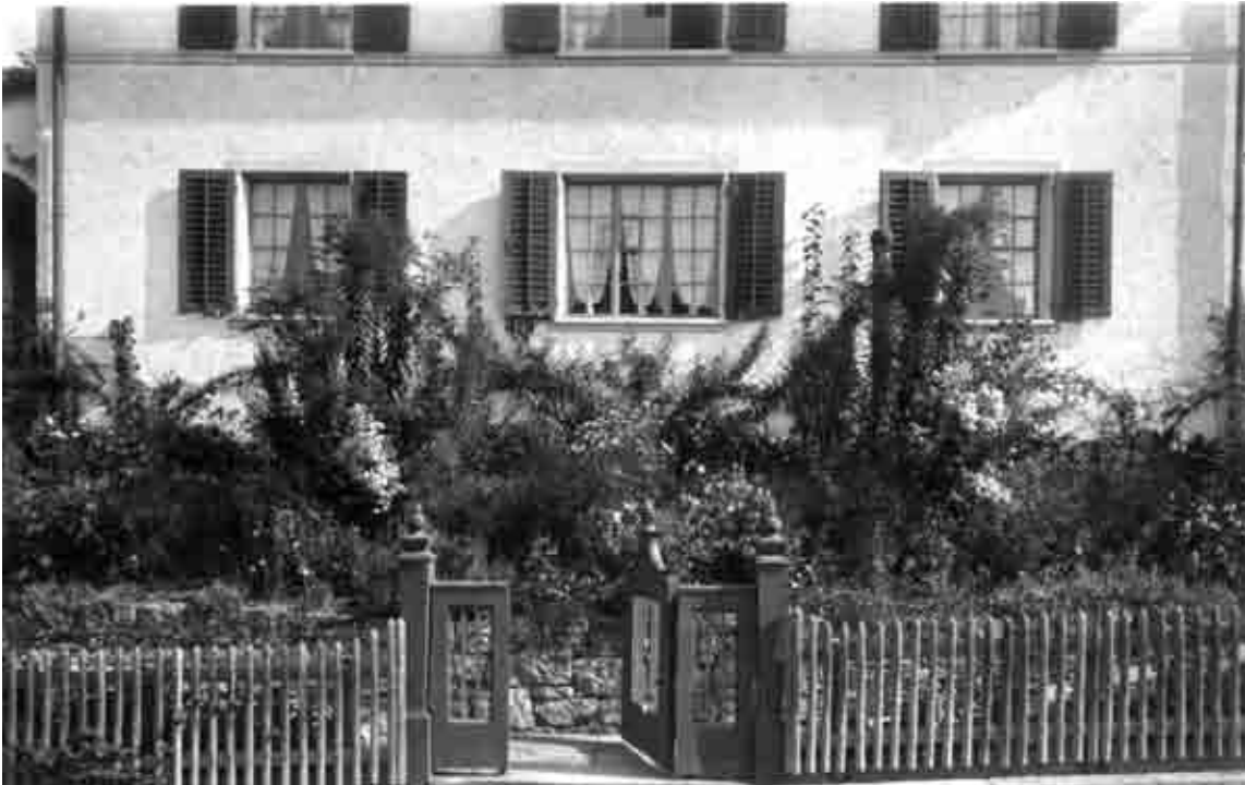
Abb. 15 Ammanns Wohnhaus in der Hirslanderstrasse in Zürich um 1926.
