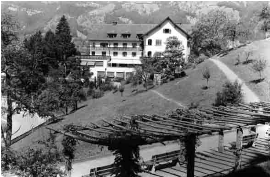
Abb. 137 Blick von der Bocciabahn auf das Haupthaus des Ferienheims Vitznau um 1942.
