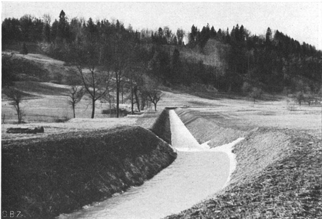
Abb. 25. Rücksichtsloser Fremdkörper im Landschaftsbild! Eine in Gefälle, Wasserführung und Kosten unspürbare, leichte S-Schwingung hätte genügt, den Bach ins Gelände einzuschmiegen
