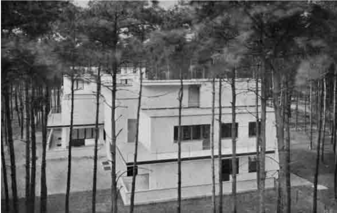
Abb. 74 Doppelhaus in der Meistersiedlung des Bauhauses Dessau. Erbaut 1925/1926 von Walter Gropius.
