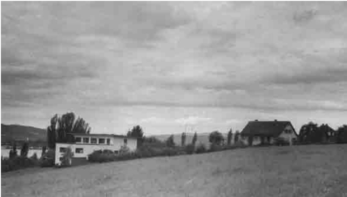
Abb. 112 Die beiden Anwesen Debrunner in Zollikon am Zürichsee in einer Fotografie von 1939.
